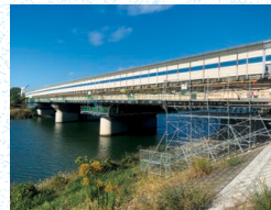
河川内での耐震補強工事
