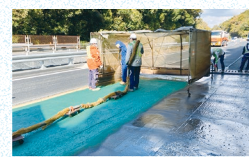
高性能床版防水施工状況
