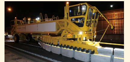
交通規制時間短縮のため、仮設防護柵を迅速に設置・撤去できるロードジッパーシステムを採用
