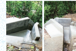
強化後の縦溝と集水ます
