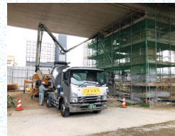
橋脚補強の施工状況
