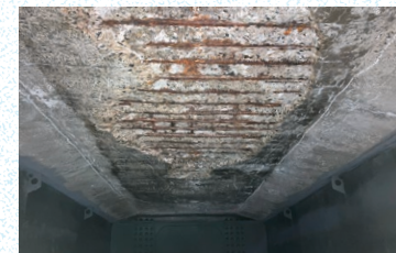
床版取替前(コンクリート床版下面)
