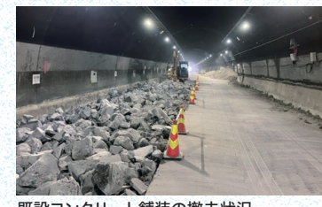
既設コンクリート舗装の撤去状況
