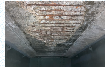
床版取替前(コンクリート床版下面)
