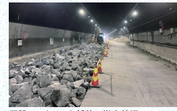
既設コンクリート舗装の撤去状況
