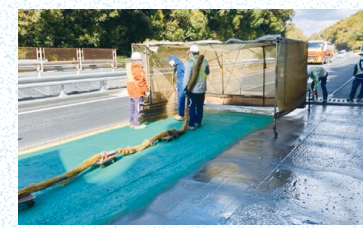
高性能床版防水施工状況
