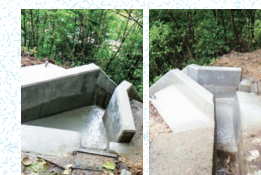
強化後の縦溝と集水ます
