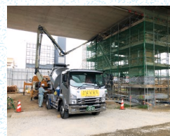
橋脚補強の施工状況
