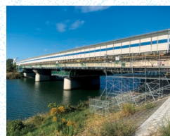
河川内での耐震補強工事
