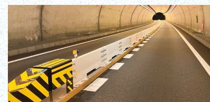
センターブロック
