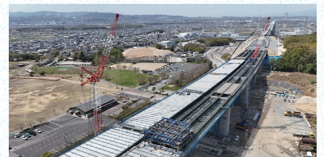
富野高架橋 上部工工事
