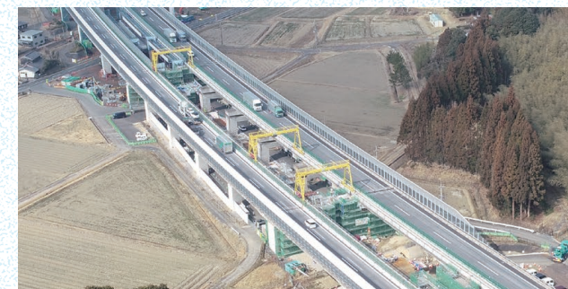
甲賀土山IC～信楽IC 6車線化工事
