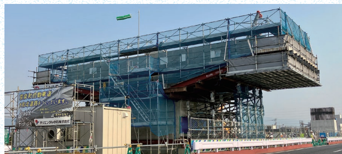
発志院北第一高架橋 下部工工事
