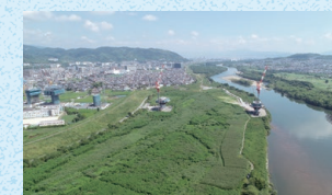
淀川橋下土工事と鶴殿ヨシ原
