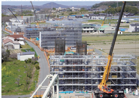
奥から第三・第四・第五平野西高架橋 下部工工事
