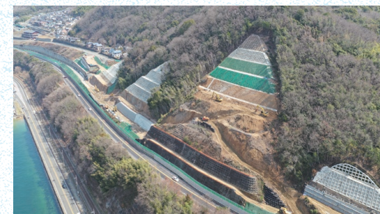
坂町植田地区～水尻地区における切土工事
