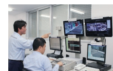
料金・ETC設備実習室
