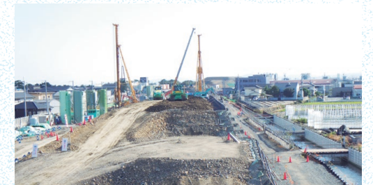
建設発生土の受け入れ
