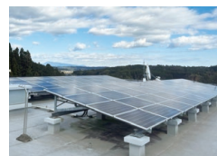
社屋屋上への 太陽光パネル設置 (九州支社 宮崎高速道路事務所)
