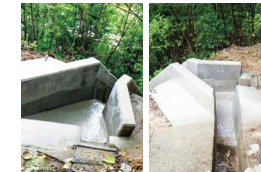
強化後の縦溝と集水ます
