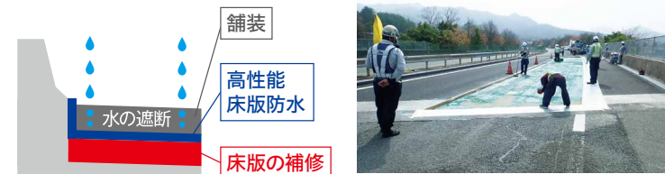
高性能床版防水施工状況
