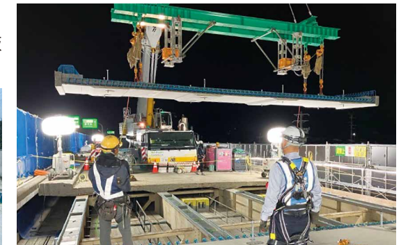
床版取替状況
