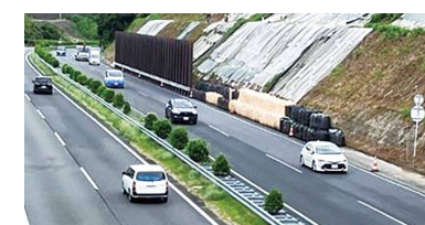
<全車線開放後>
