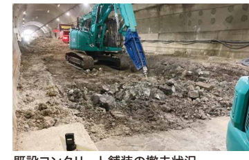
既設コンクリート舗装の撤去状況
