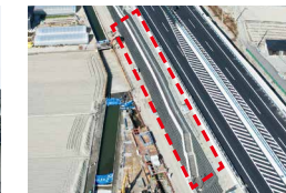
徳島南部道本線橋の津波避難場所(赤枠内)
