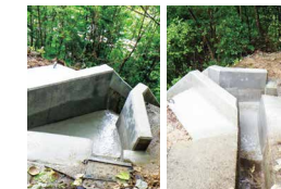
強化後の縦溝と集水ます
