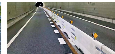
センターブロック
