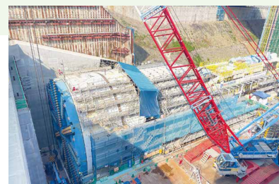
枚方トンネル掘削の準備工事
