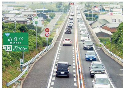
阪和道(印南IC～みなべIC)
