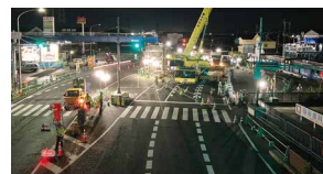
大江第一高架橋他4橋(下部工)工事
