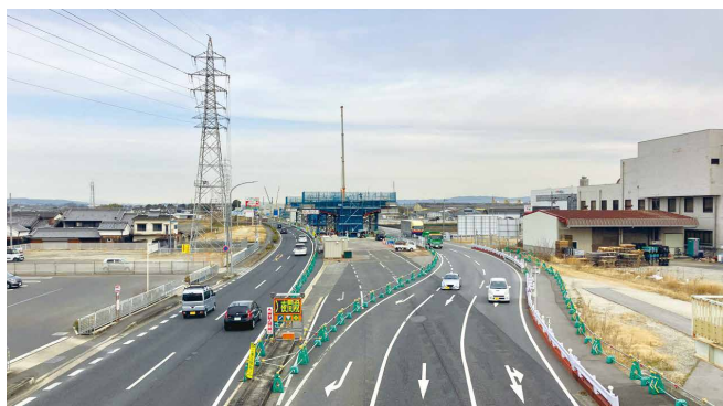
国道24号線交通規制状況
