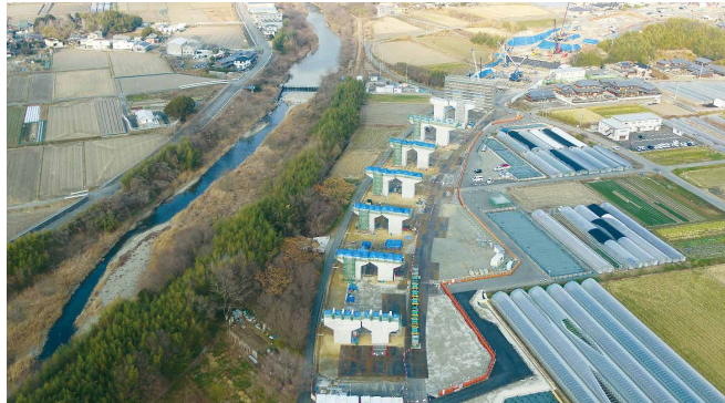
平野東高架橋他6橋(下部工)工事
