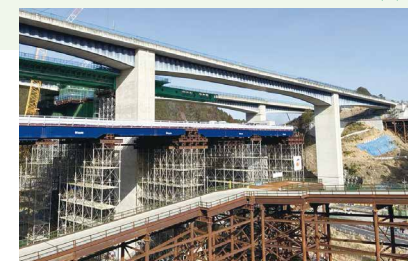
杉谷川橋(下)PC上部工事
