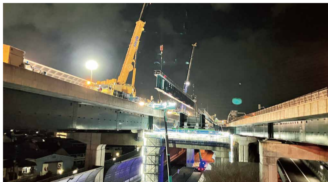
門真高架橋東(鋼上部工)設計・工事
