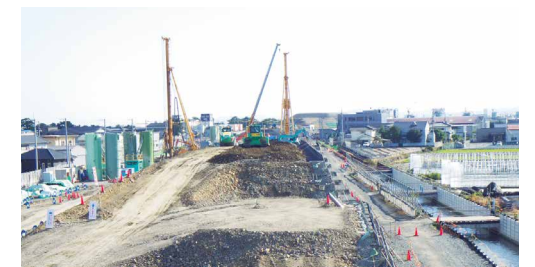
建設発生土の受け入れ
