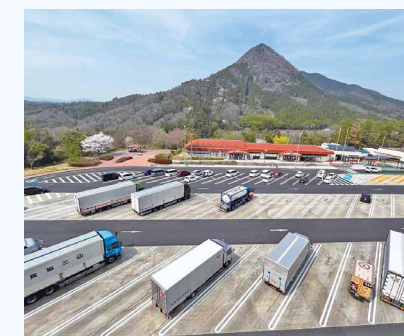
駐車マス拡充 (中国道 安佐SA(上))
