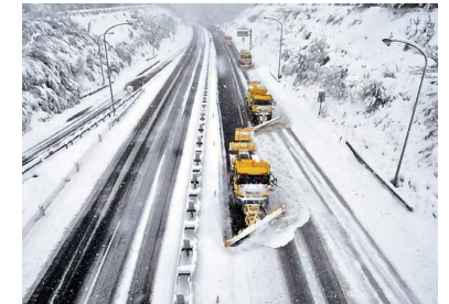
除雪作業状況
