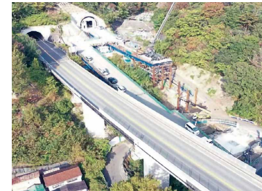
広島呉道路4車線化工事
