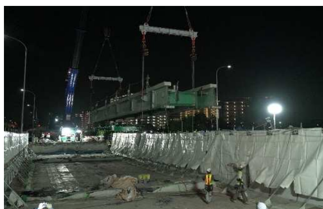
中国自動車道 御堂筋橋 （大規模更新／高速道路の長期保全）
