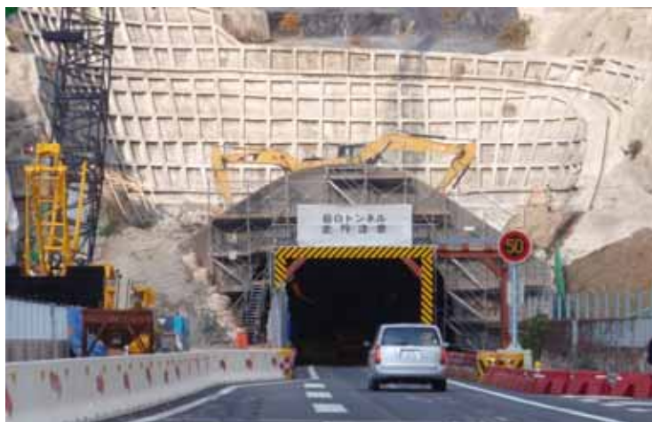
藤白トンネル防護工設置状況
