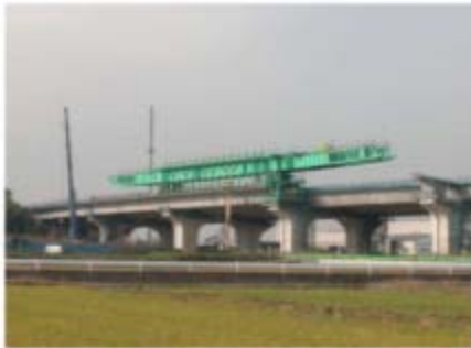
交野高架橋(最大支間長39.5m) 出典:三信工業(株)HPより引用
