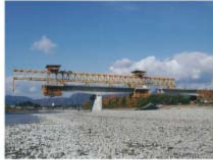
長良川橋(最大支間長111.0m) 出典:P&Z協会HPより引用
