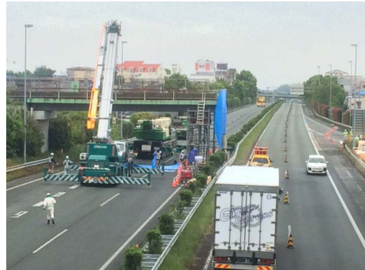
復旧作業状況(25日 13時時点)
