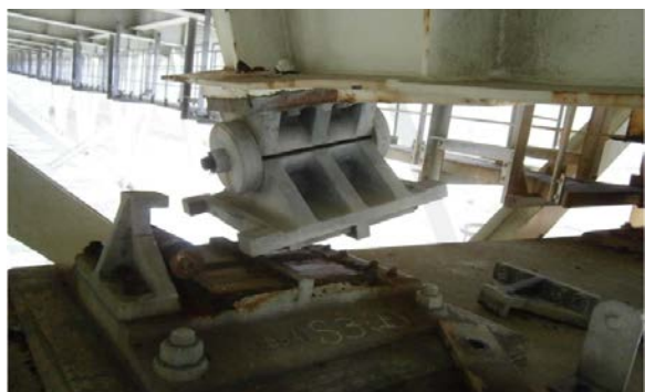
⑦大分自動車道(湯布院IC～日出JCT) 92.5kp 付近 並柳橋の被害状況
