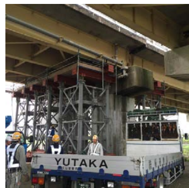
復旧作業状況(25日 13時時点)
