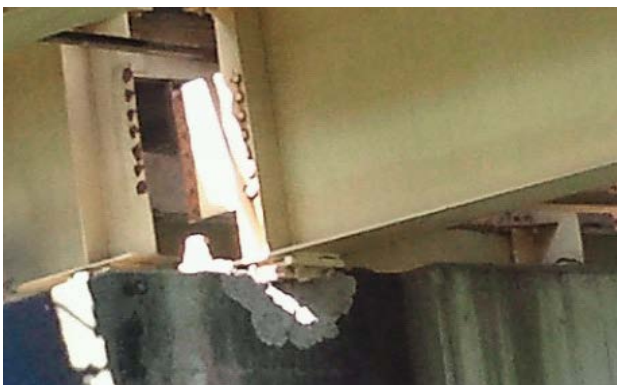
④九州自動車道 (益城熊本空港 IC~嘉島 JCT) 179.6kp 付近 木山川橋の被害状況
