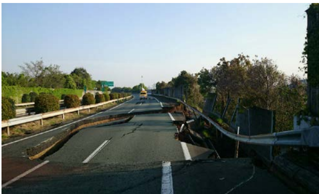
④九州自動車道 (益城熊本空港 IC~嘉島 JCT) 179.6kp 付近 木山川橋の被害状況
