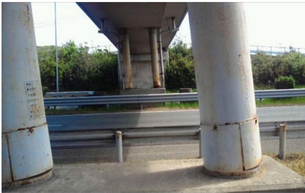
②九州自動車道 熊本 IC 跨道橋(市道石原町長峰第1号 神園橋)の被害状況
