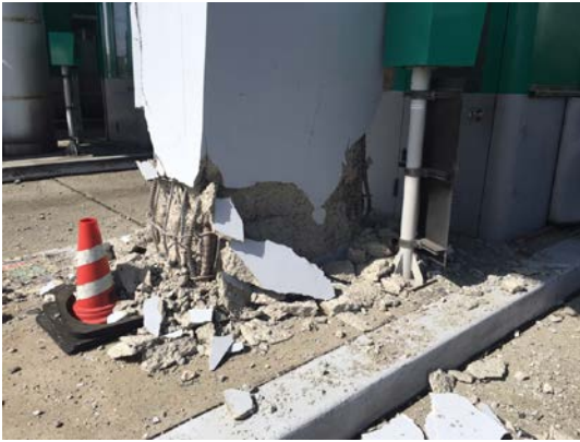
①九州自動車道(熊本 IC) 熊本料金所トールゲートの被害状況
