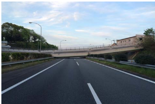
⑤九州自動車道 緑川PA(御船IC～松橋IC) 跨道橋(県道 32 号小川嘉島線 府領第一橋)の被害状況
