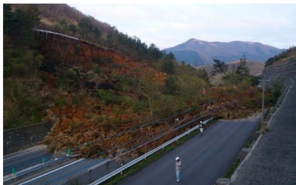
⑥大分自動車道(湯布院IC～日出JCT) 93.7KP のり面土砂崩落箇所の被害状況
