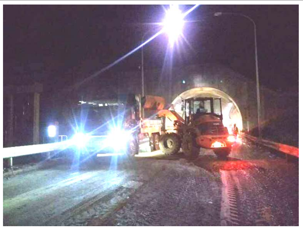
復旧作業中の状況(7/10 夜)
