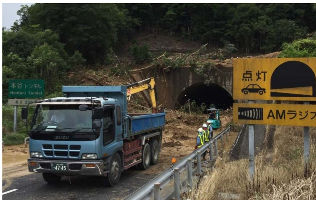
復旧作業中の状況 (7/7 昼)
