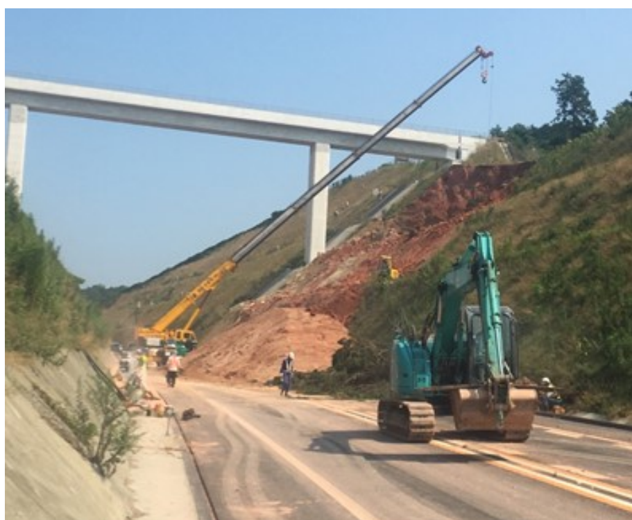
復旧作業中の状況(7/16 昼)
