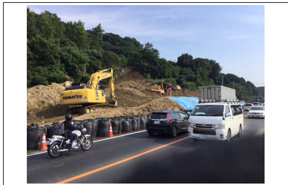
土砂排出作業の状況(7/17 昼)
