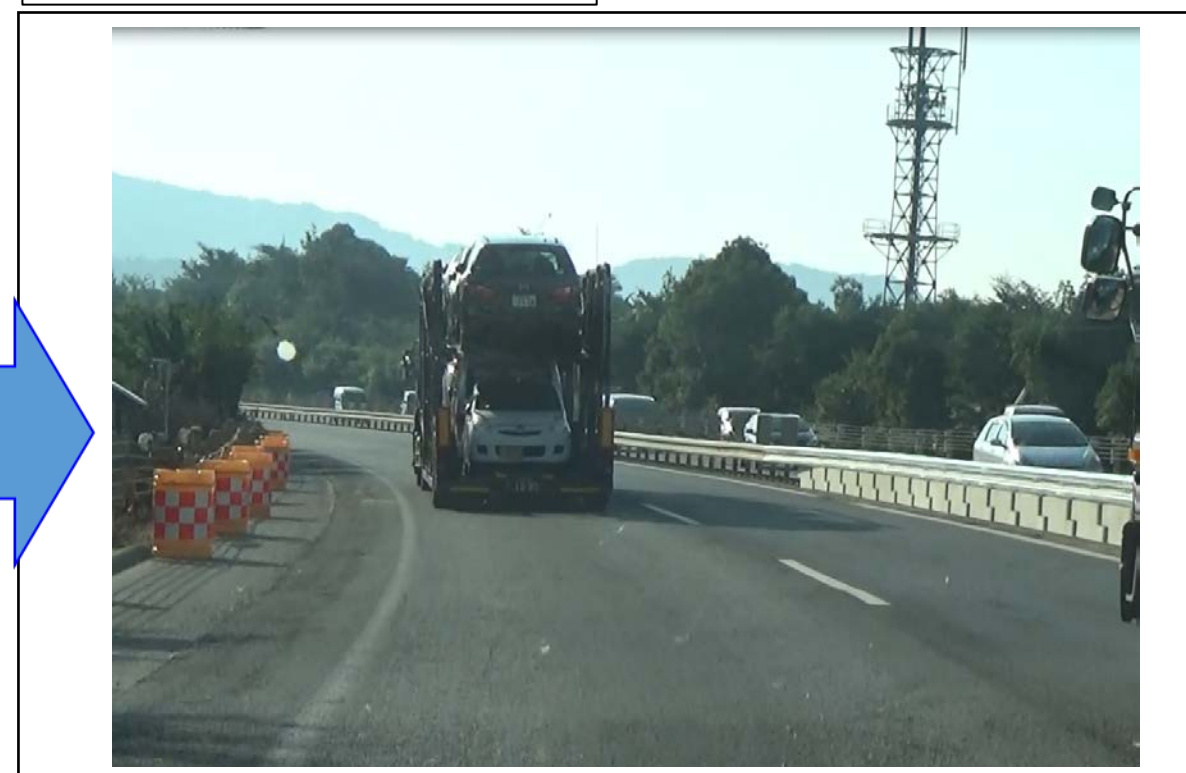
通行止め解除後の状況
