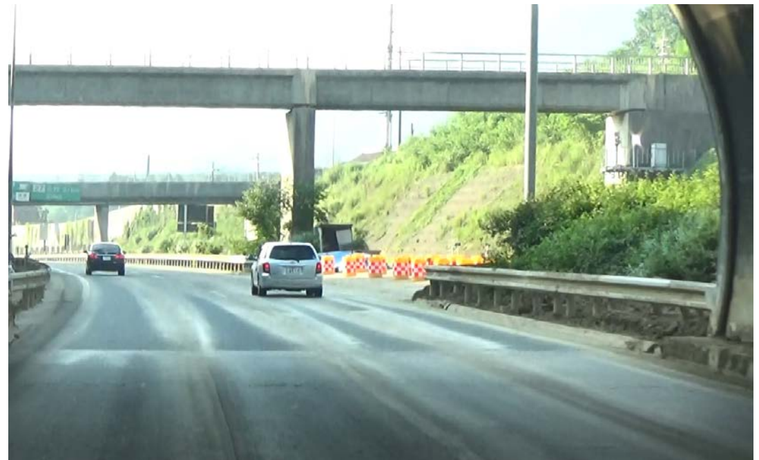
通行止め解除後の状況
