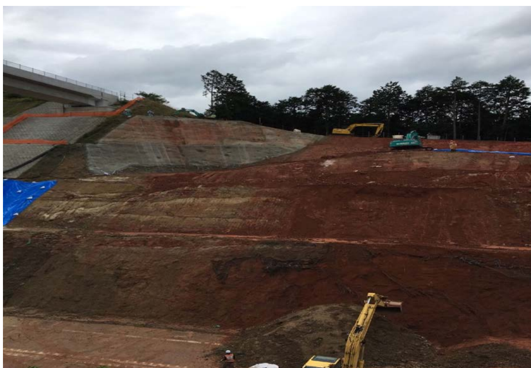
復旧作業中の状況(7/30 昼)
