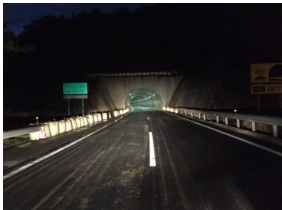
通行止め解除後の状況
