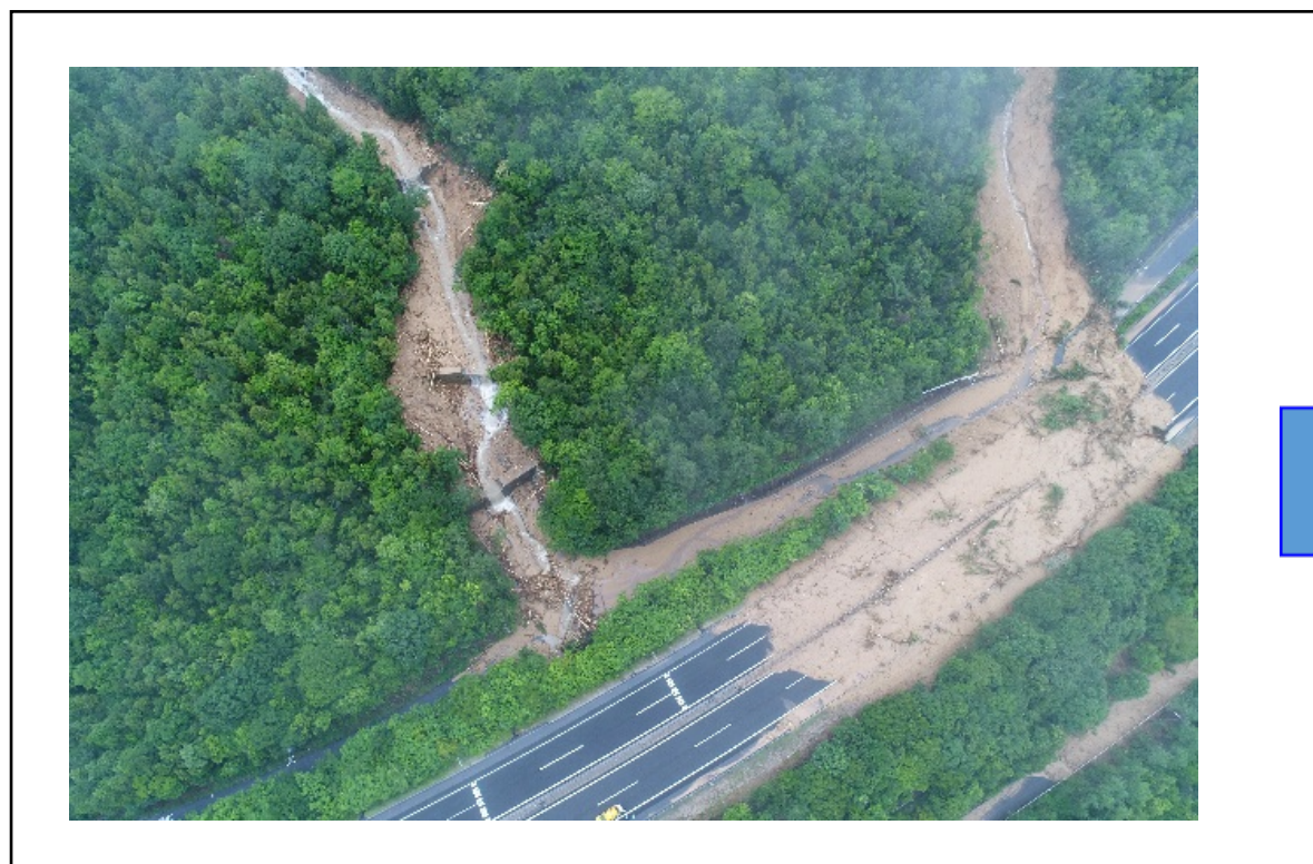
被災時の状況
