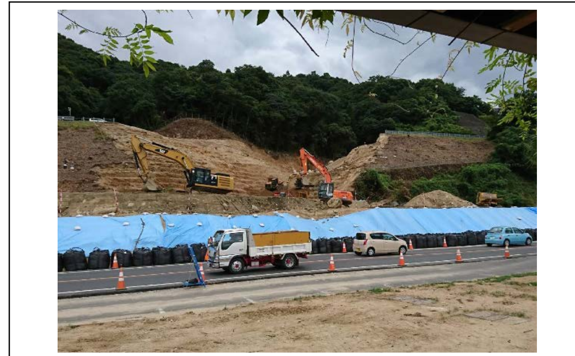
土砂搬出作業の状況(7/30 昼)
