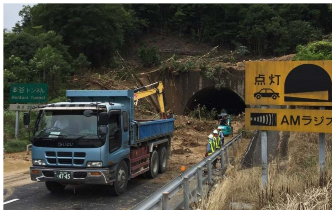
復旧作業中の状況 (7/7 昼)
