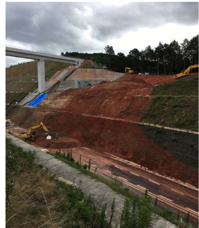
現在の復旧状況(7/30 昼)
