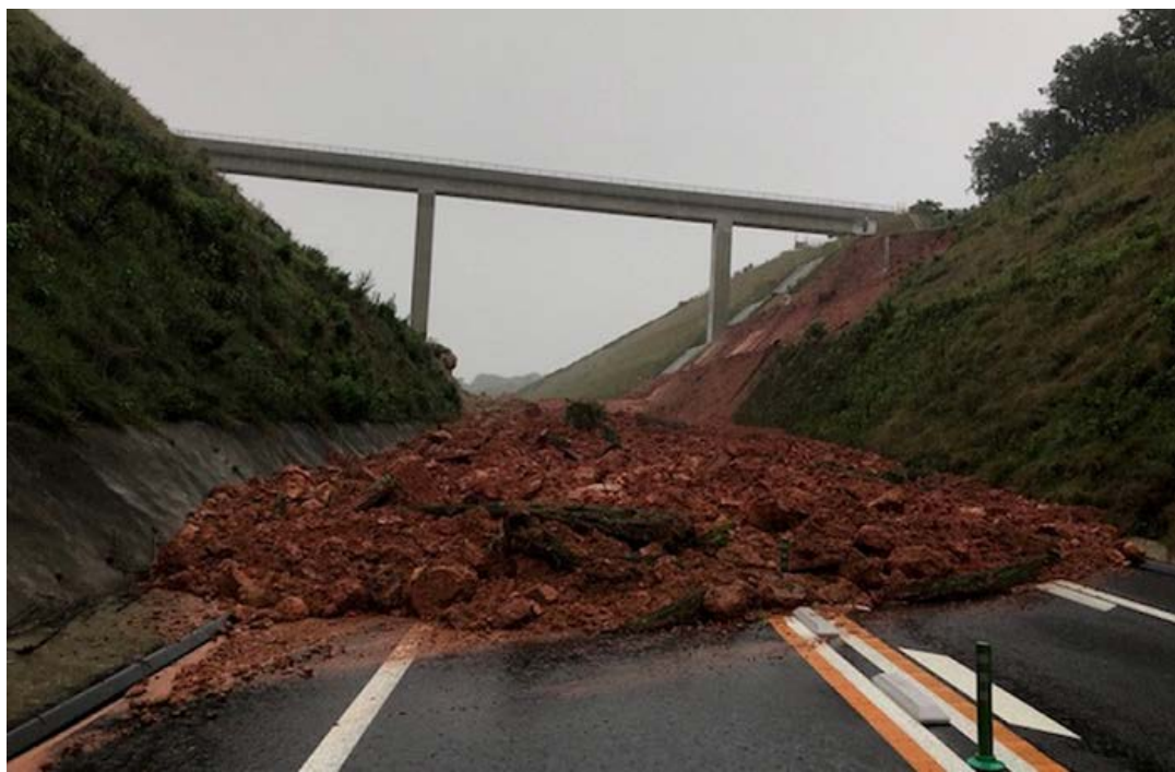
被災時の状況
