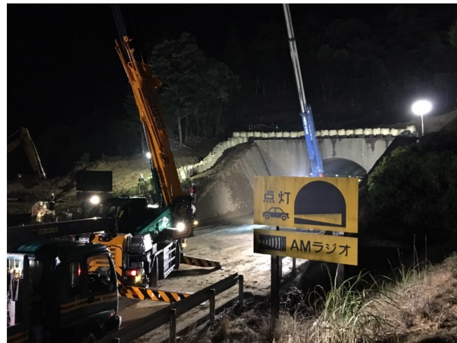
復旧作業中の状況 (7/9 夜)
