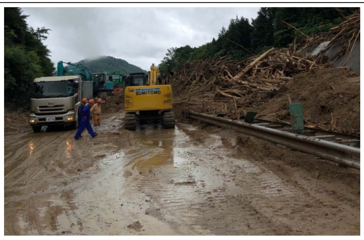
復旧作業中の状況(7/10 昼)
