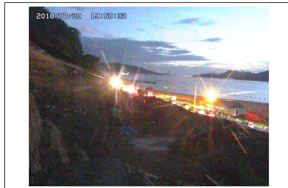
土砂排出作業の状況(7/30 夜)
