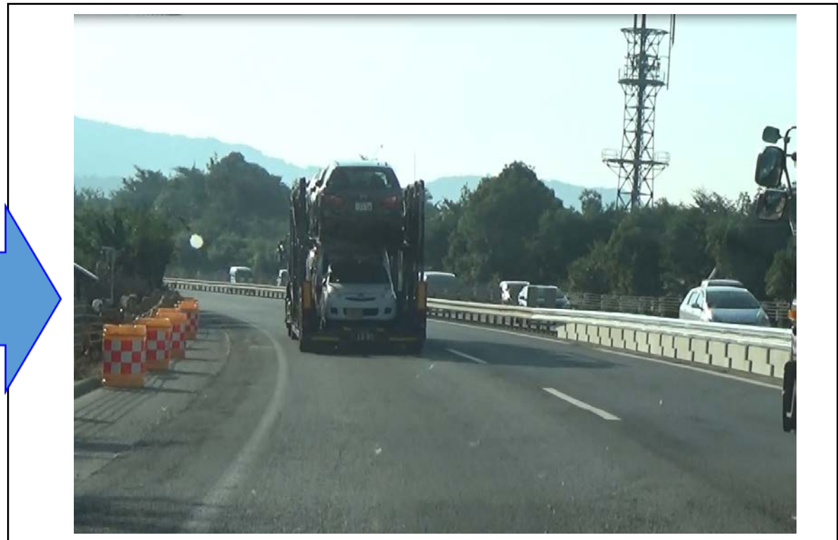
通行止め解除後の状況
