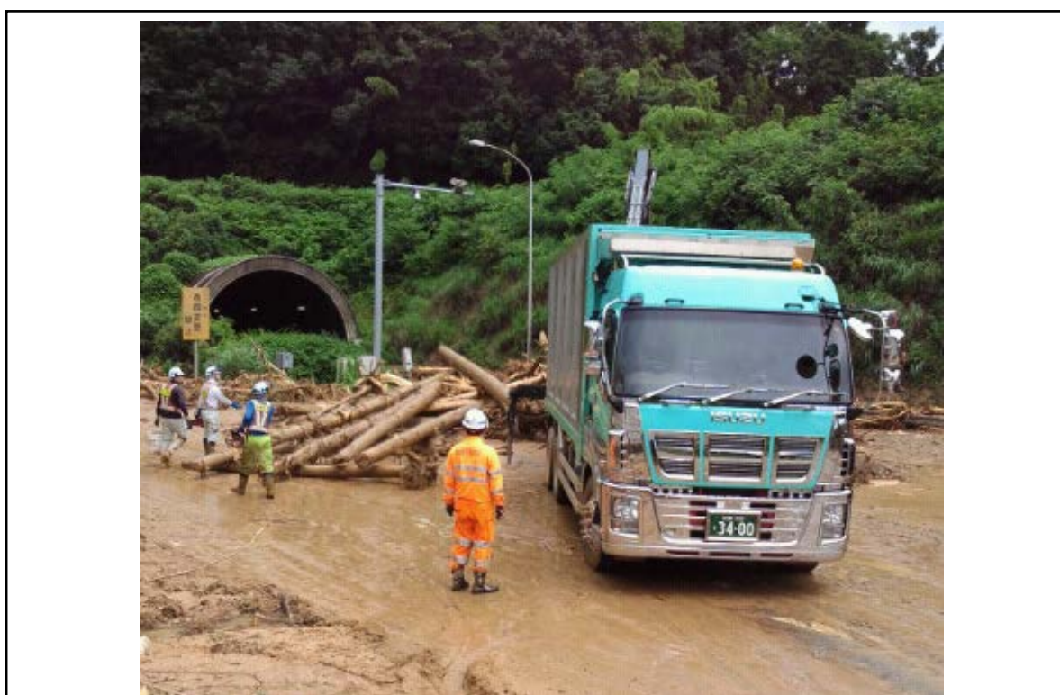
復旧作業中の状況(7/10 昼)
