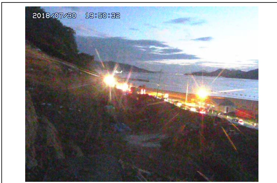
土砂排出作業の状況(7/30 夜)
