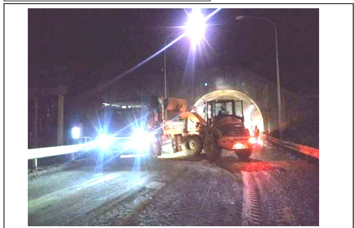
復旧作業中の状況(7/10 夜)
