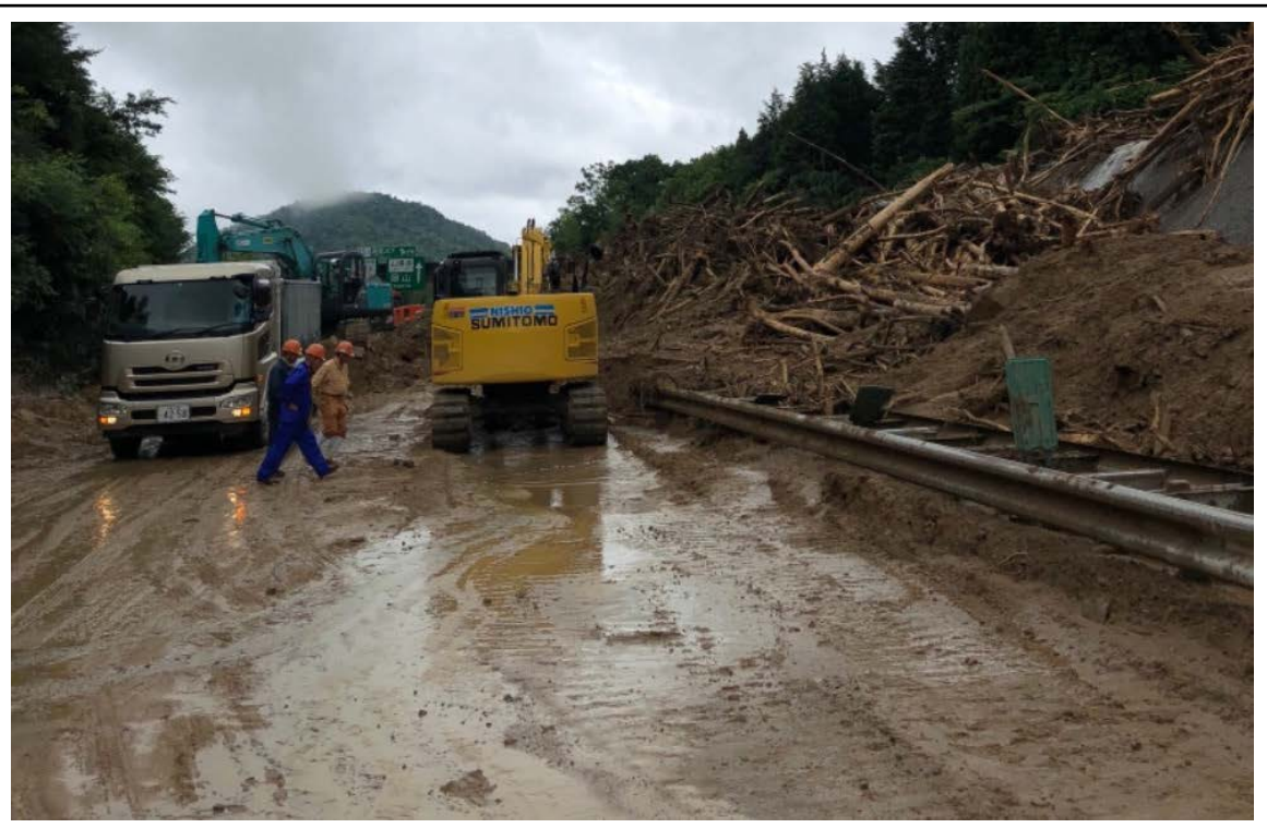
復旧作業中の状況(7/10 昼)
