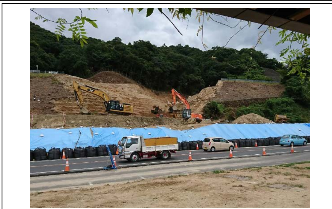
土砂搬出作業の状況(7/30 昼)
