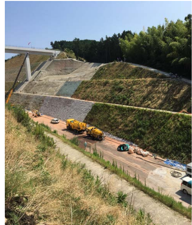
復旧作業中の状況(8/6 昼)
