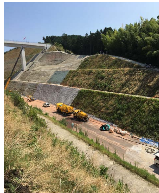
復旧作業中の状況(8/6 昼)
