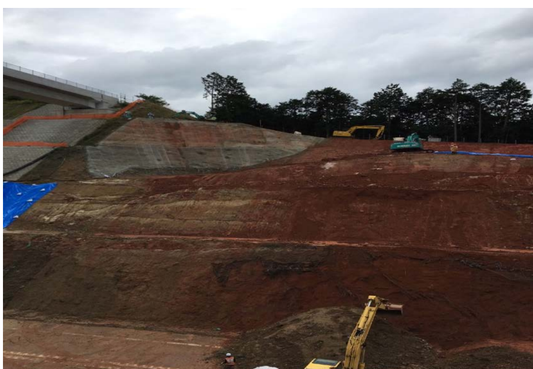
復旧作業中の状況(7/30 昼)
