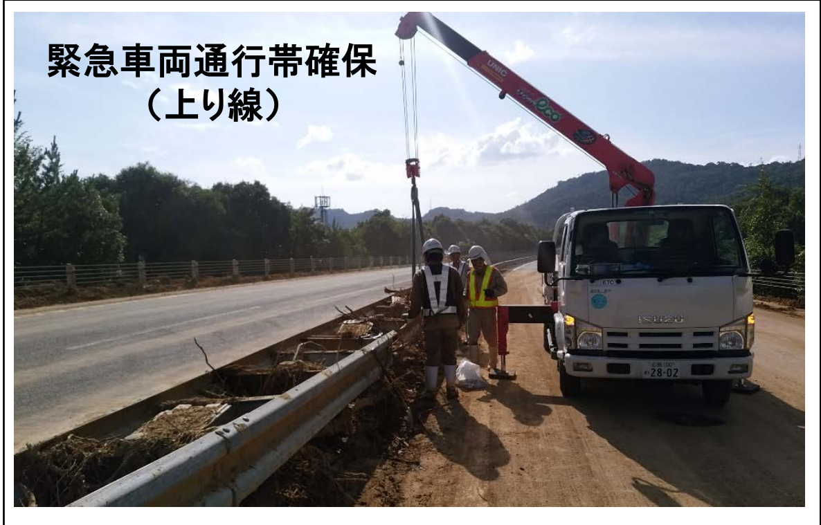
復旧作業中の状況(7/10 夜)
