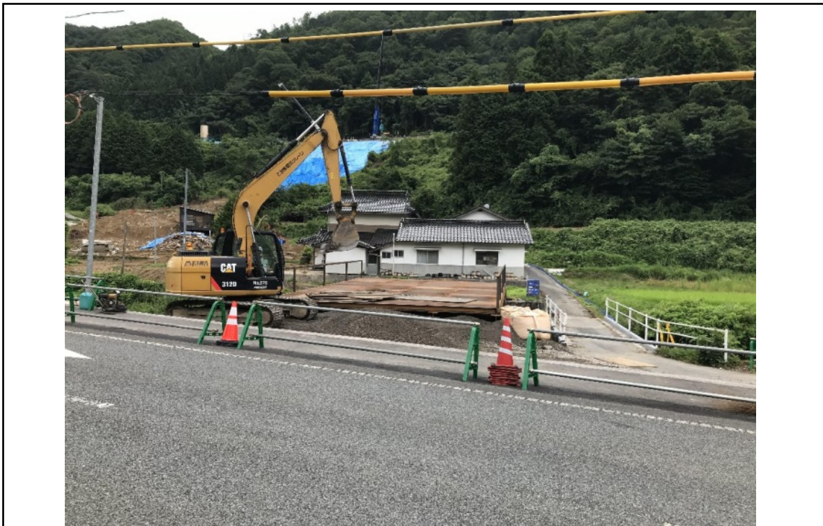
仮棧橋工設置作業中 (7/30 昼)
