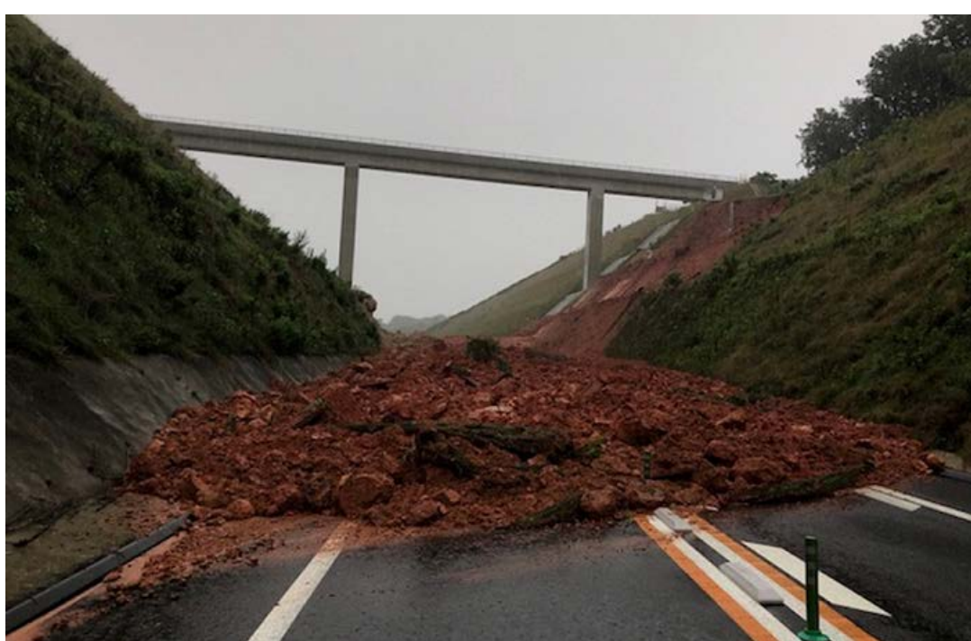
被災時の状況
