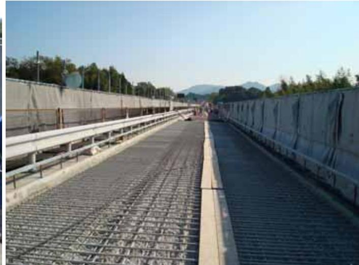
劣化したコンクリートの除去完了状況（11月9日撮影）
