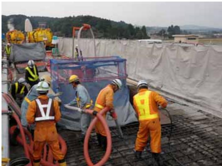
劣化したコンクリートの除去作業状況（10月13日撮影）
