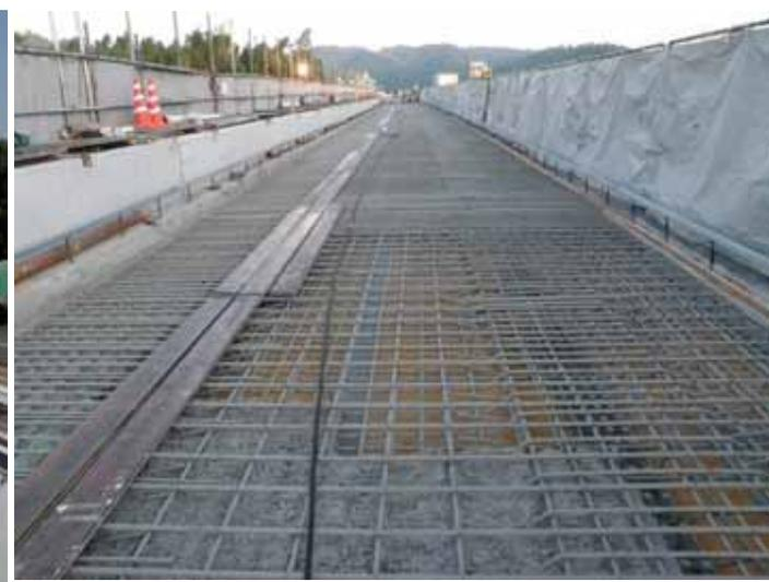
劣化したコンクリートの除去完了状況（10月22日撮影）
