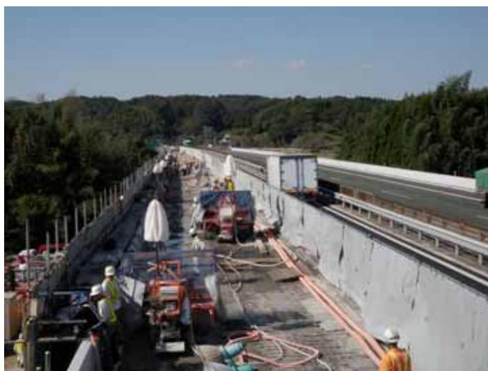
劣化したコンクリートの除去作業状況（10月20日撮影）
