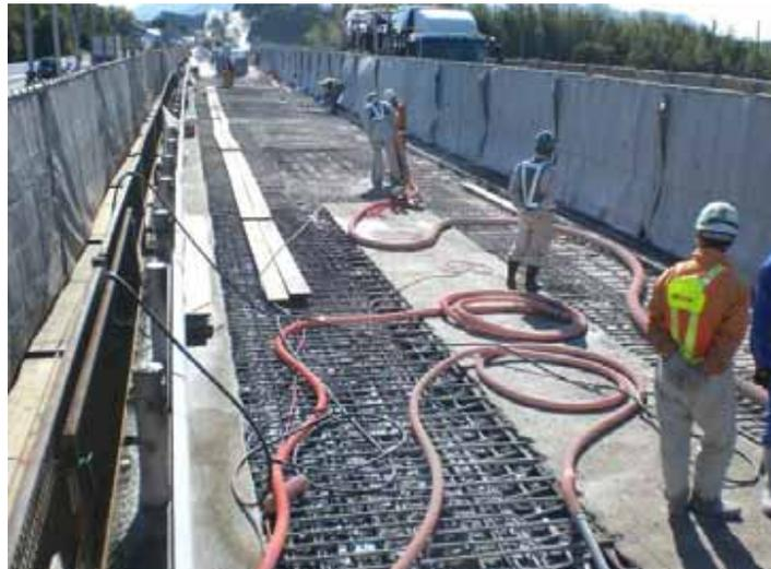
劣化したコンクリートの除去作業状況（11月4日撮影）
