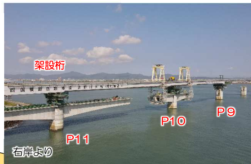
右岸側施工状況
