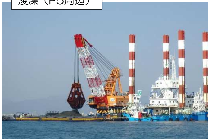
浚渫（P5周辺）
