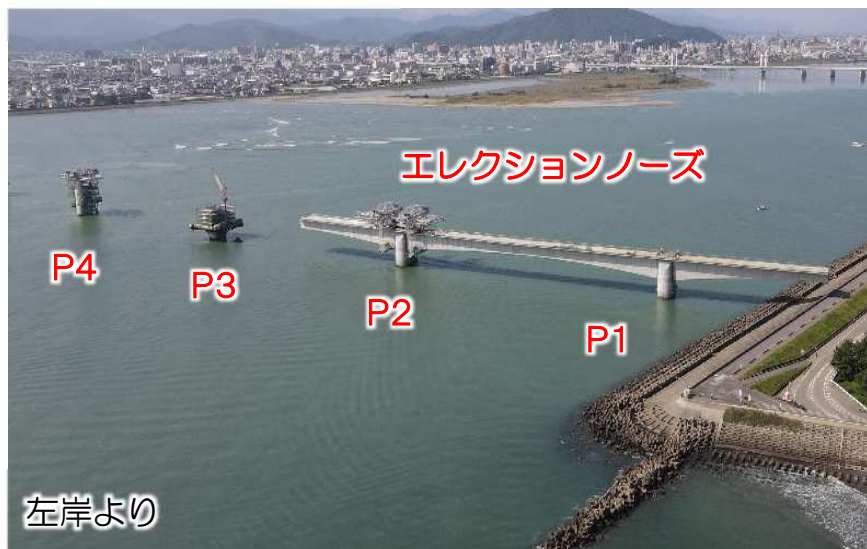
左岸側施工状況
