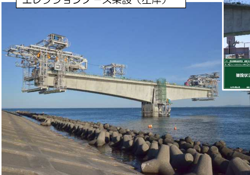
エレクションノーズ架設（左岸）
