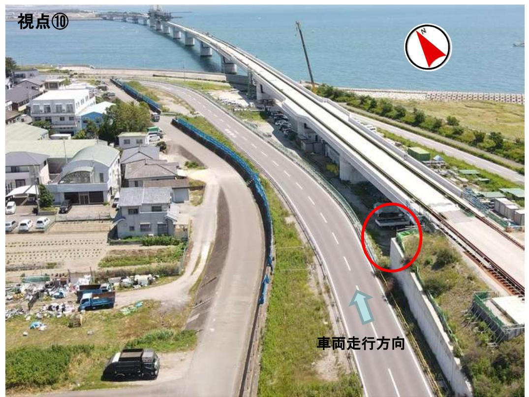
両側港湾道路は一方通行のため、北向き走行時には土留擁壁により、橋台部の排水管や検査路は見えない構造である。
