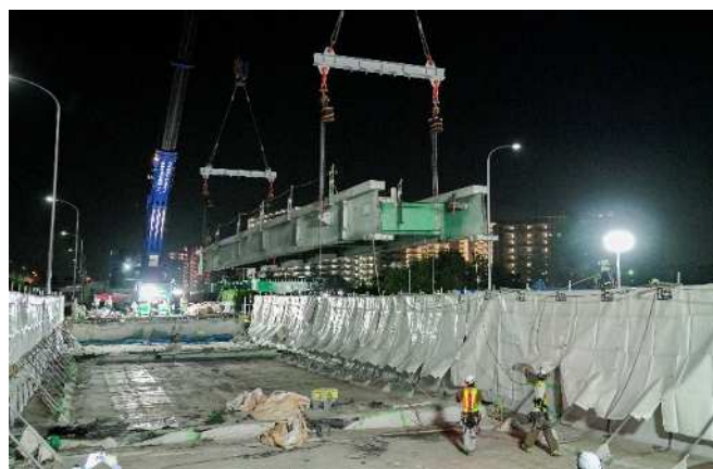
中国自動車道 御堂筋橋 (大規模更新/高速道路の長期保全)
