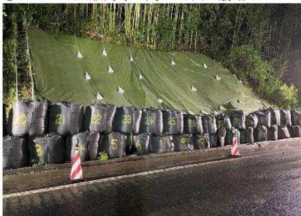
土砂を撤去し、ブルーシートにより養生し、土嚢押さえによる応急対策を実施しました。
