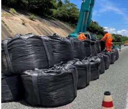
上り線側法面の変状箇所をブルーシートにより養生の上、土嚢等を設置し、万が一、崩落が発生しても本線へ被害が及ばないように対策を実施し、7/11 13:33 に下り線を先行して通行止めを解除しております。現在は上り線の通行止め解除に向け、更なる安全対策を実施しております。
