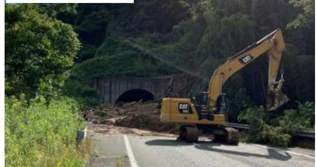
高山トンネルは東西の坑口付近において、高速道路外から土砂等が大規模に流入しており、それらの撤去や道路設備の修繕と並行し、崩落箇所の安全確認及び対策を実施しております。
