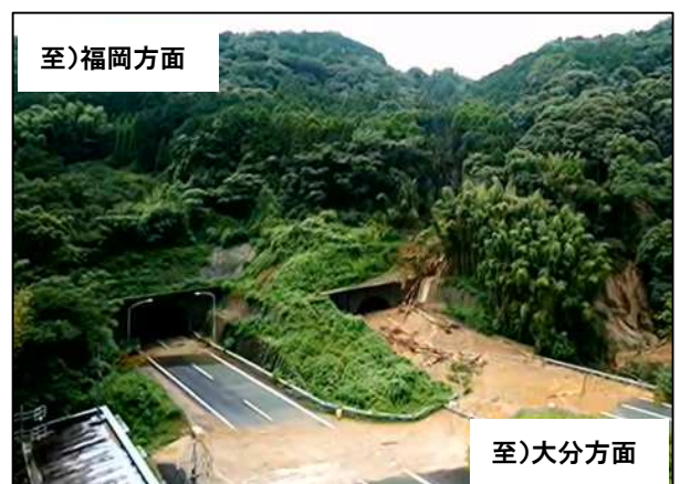
こうやま (高山トンネル東坑口)
