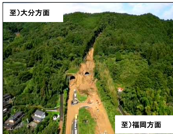
こうやま (高山トンネル西坑口)
