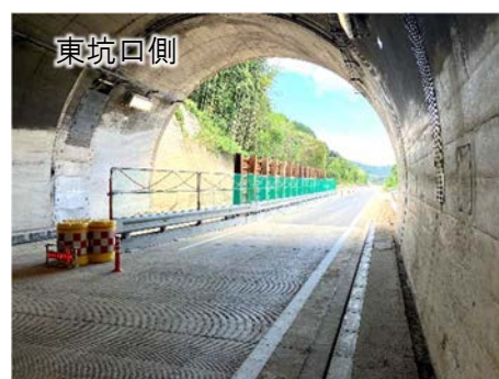
仮設防護柵設置状況
