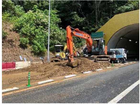
内久井トンネル西坑口復旧作業状況
