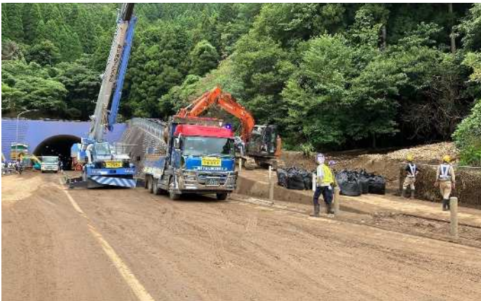
坊口トンネル東坑口復旧作業状況
