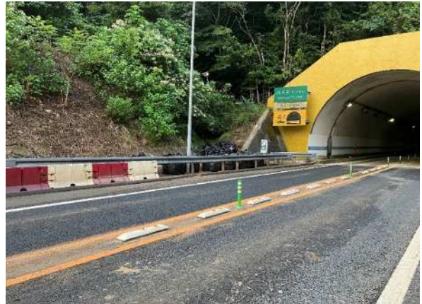
内久井トンネル西坑口復旧作業状況
