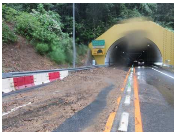
内久井トンネル西坑口 (宮津方面から亀岡方面を望む)
