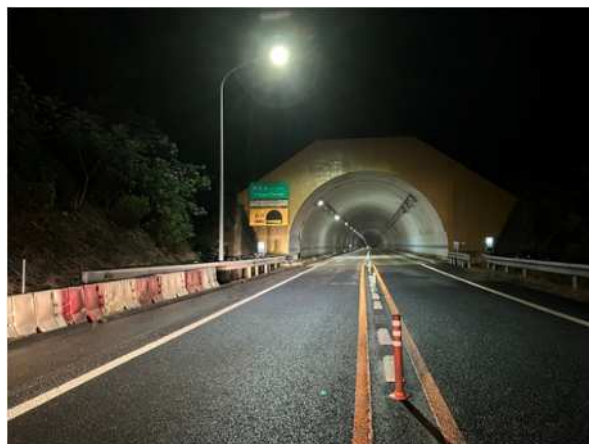
内久井トンネル西坑口復旧完了
