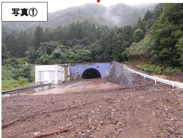
坊口トンネル東坑口 (亀岡方面から宮津方面を望む)
