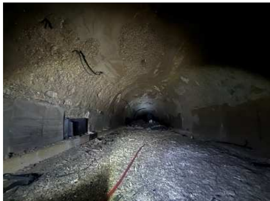
トンネル内部(全景)
