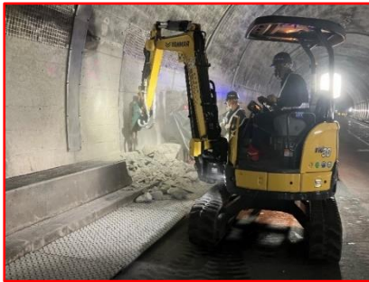
トンネル非常用設備(配水管等)撤去
