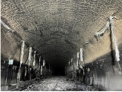
トンネル内部(全景)
