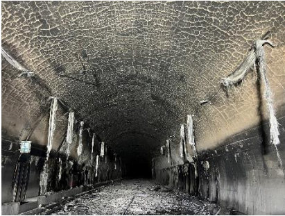
トンネル内部(全景)
