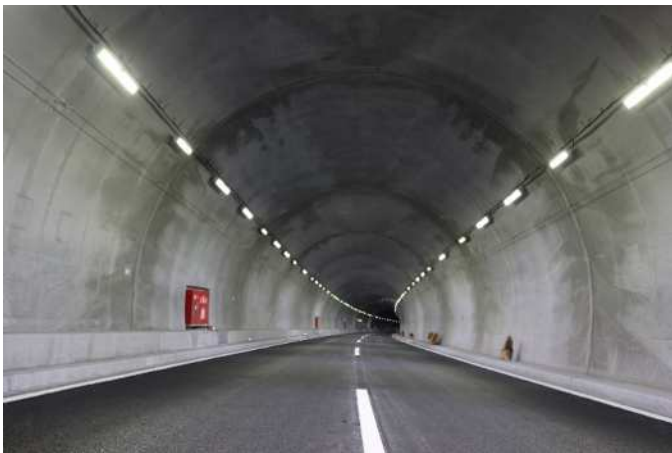
トンネル内部(全景)
