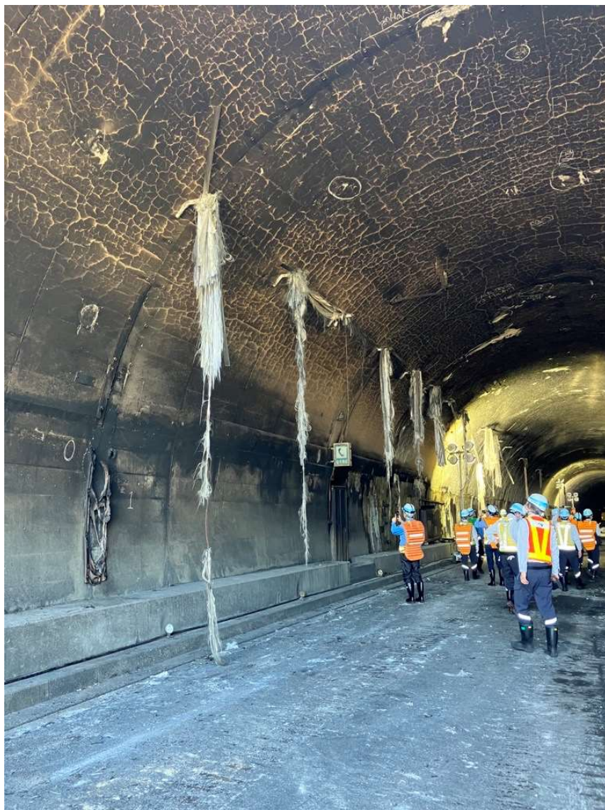
走行車線側側壁（岡山方面を望む）
