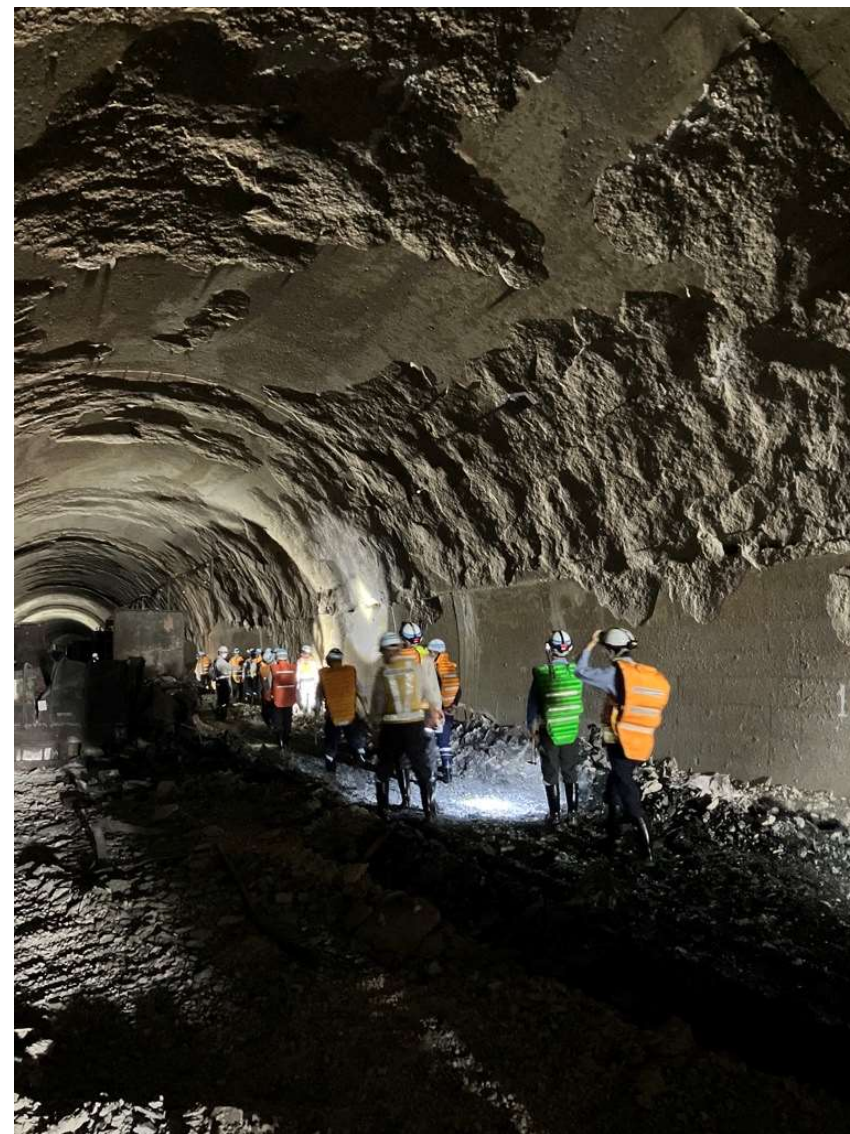
追越車線側側壁（岡山方面を望む）
