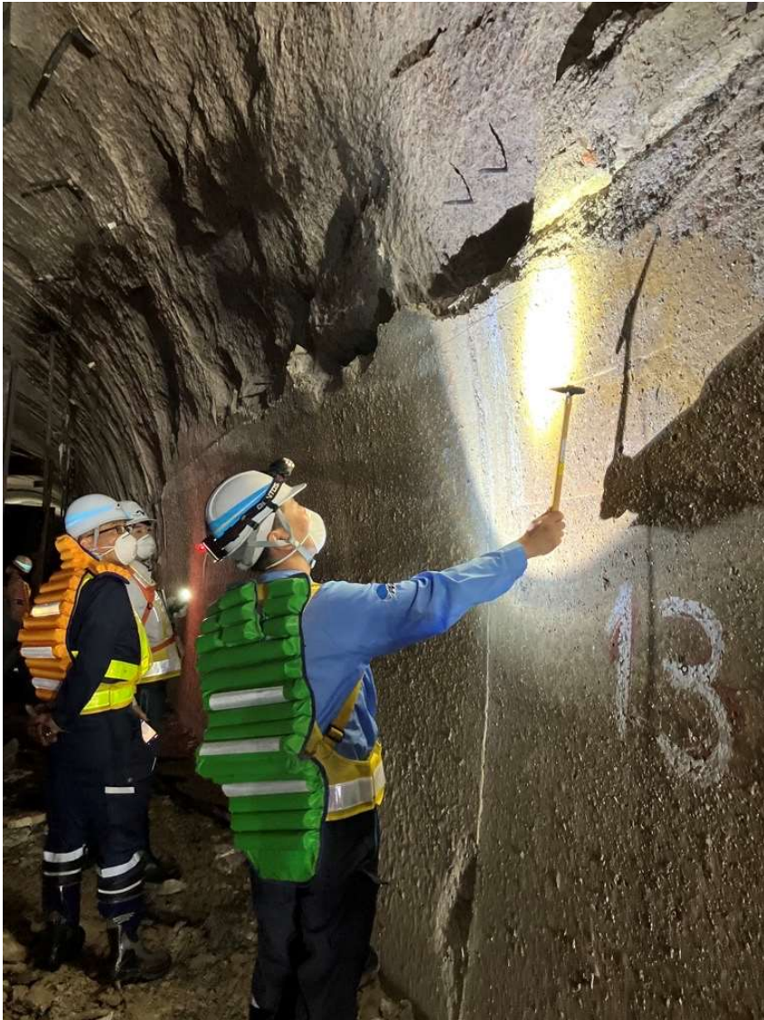
追越車線側側壁（岡山方面を望む）
