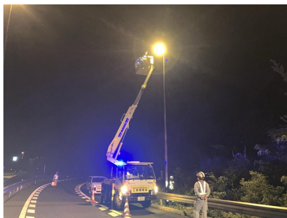
《点検作業状況》
