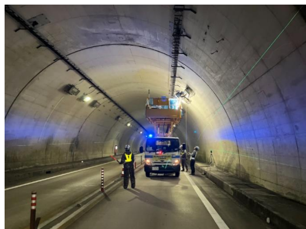
《設備更新作業状況》
