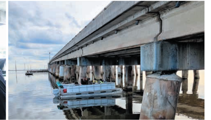
フロリダ州で実施した橋梁の赤外線点検： ボートから撮影してコンクリートの損傷を検出した／ Infrared Thermography Inspection in Florida. The concrete defects were detected by the images taken from a boat.
