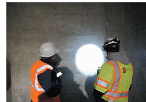
現場におけるひび割れ幅の検証作業／ Crack Width Validation in the Field
