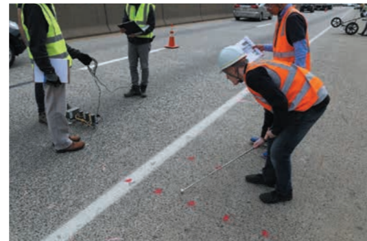
打音点検による赤外線技術の精度検証試験／ Validation for Infrared Thermography Technology by Sounding Test
