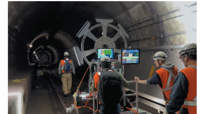
ワシントン・メトロの地下鉄トンネルにおいて漏水点検を実施： 地下鉄の安全な運行に寄与した／ Washington Metro Tunnel Water Infiltration Inspection: Contributed to the safety of subway operation
