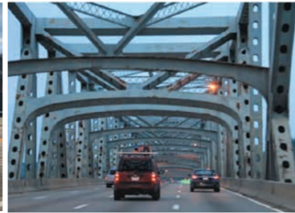
オハイオ州道路橋床版上面点検： 片側4車線の道路橋を時速60マイル(約96km)で 走行しながら点検／ Bridge Deck Top Inspection in Ohio: A Four-lane bridge deck was inspected while driving at 60mph (96km/h)
