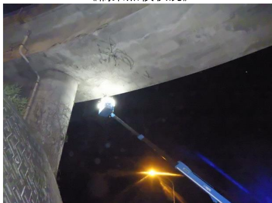
《橋梁点検状況》
