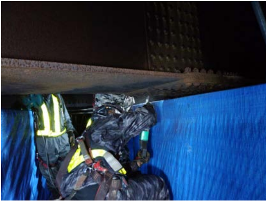
<橋梁補修作業>
