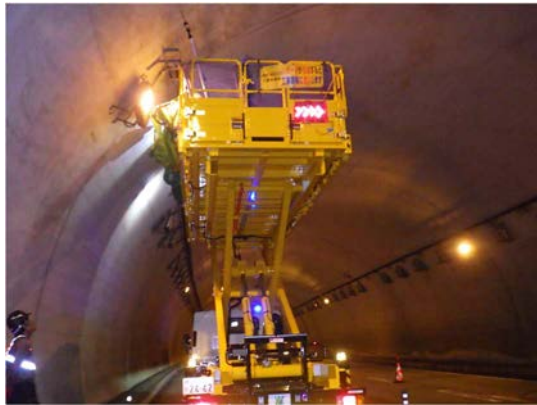
<トンネル設備点検>
