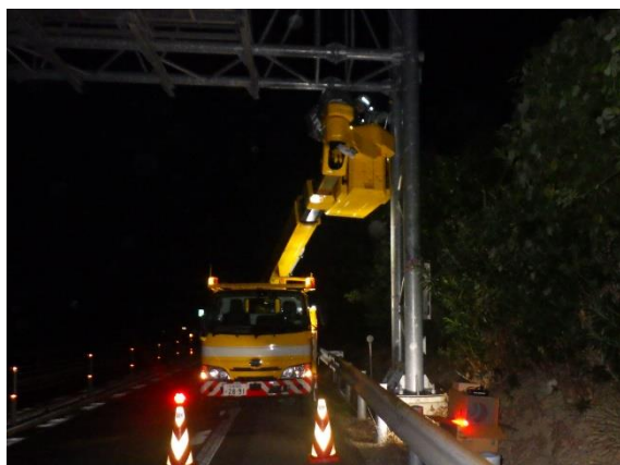
《点検作業状況》
