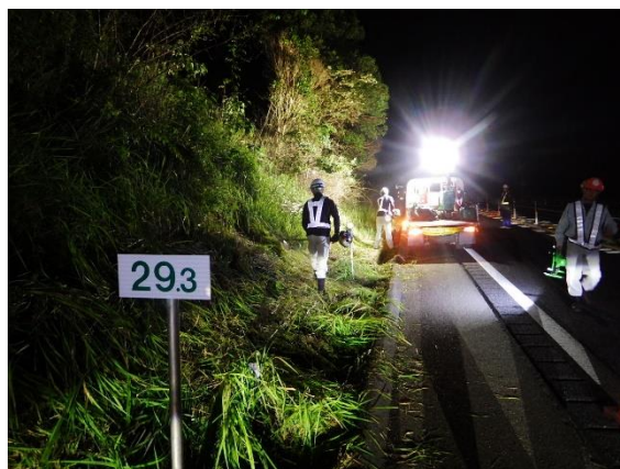
《伐採作業状況》
