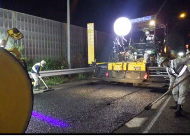
《舗装補修状況》
