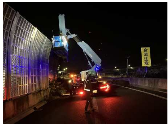
《道路附属物点検状況》
