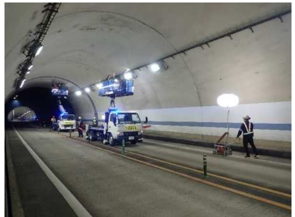
《トンネル設点検状況》
