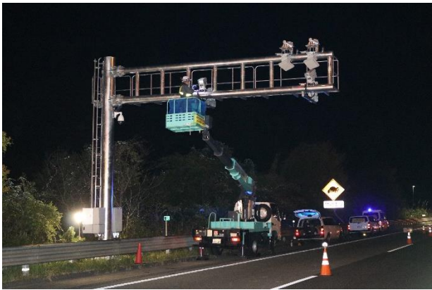
《道路設備更新作業状況》
