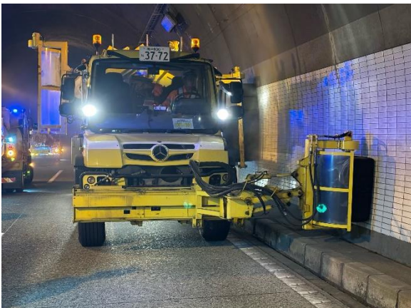
《トンネル清掃作業状況》
