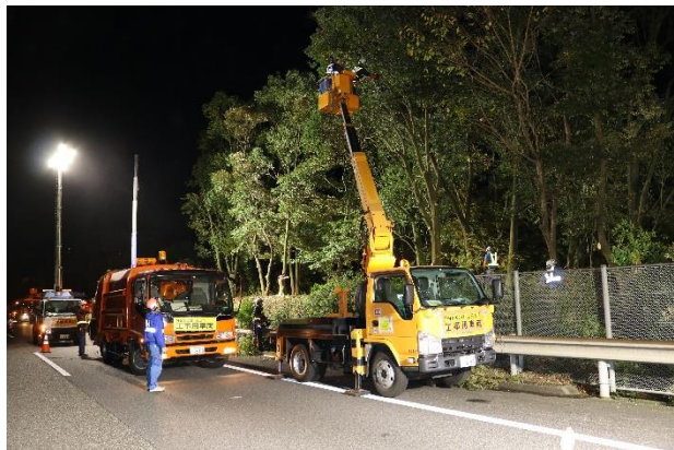
《樹木伐採作業状況》
