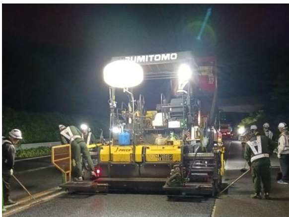
〈舗装補修工事〉
