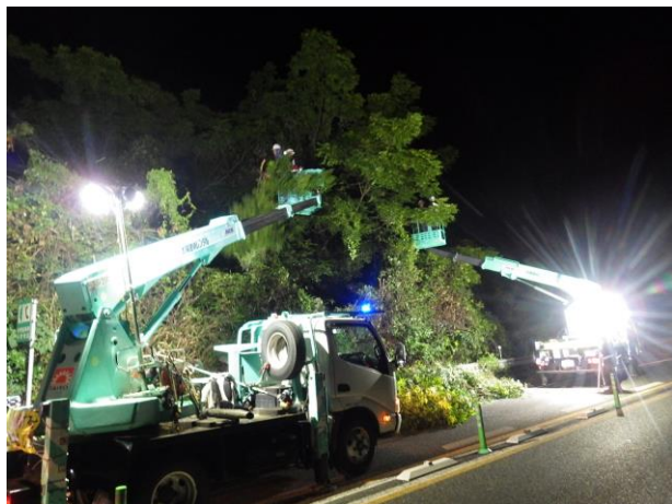
〈樹木伐採作業〉
