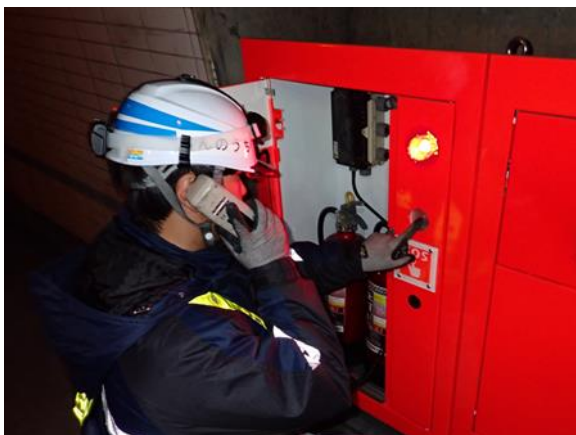
〈トンネル非常用設備点検〉
