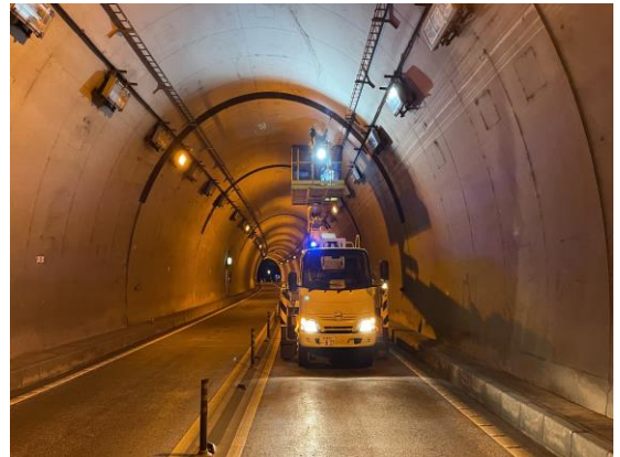
<トンネル点検>
