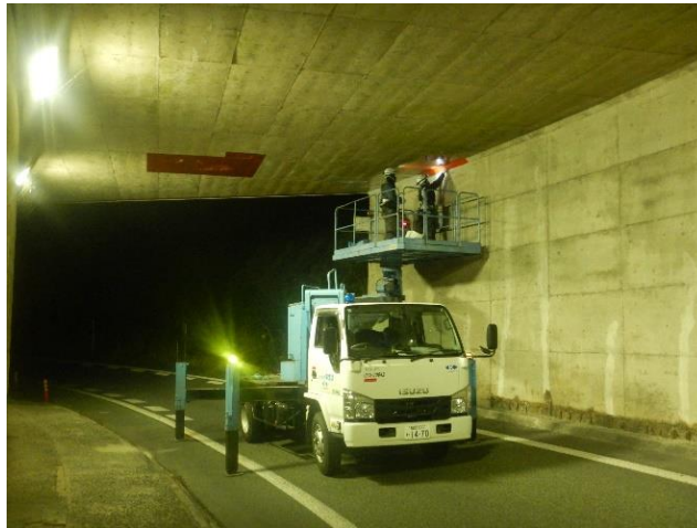
<道路構造物補修>
