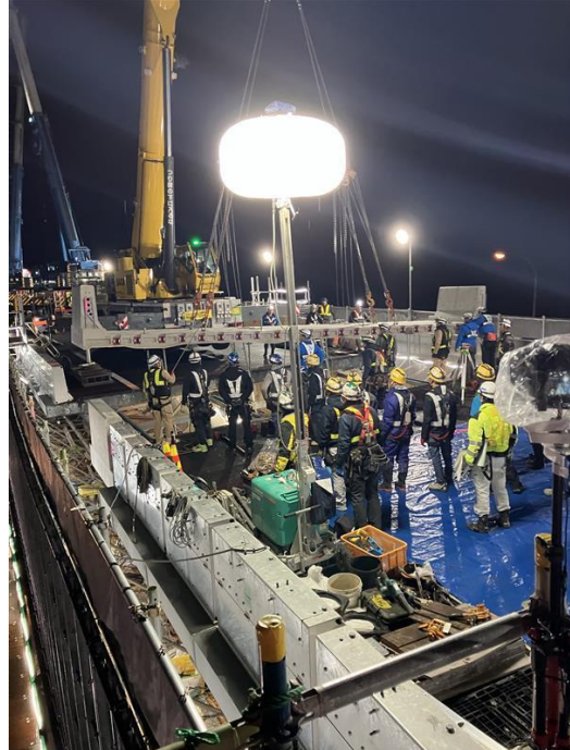
《新設床版設置状況》
