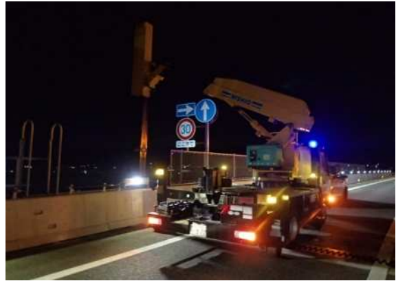
《電線路設備点検状況》
