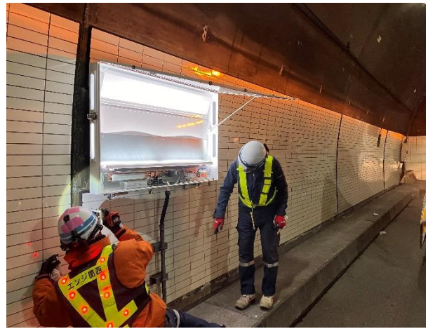
《トンネル内設備清掃状況》
